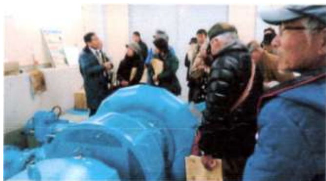
小水力発電、中津川市 12/1
