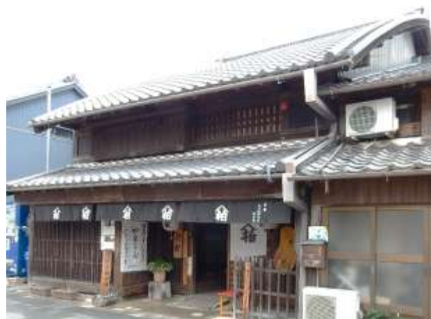
中本町 旧磯部邸 主屋 慶応年間建築 呉服商 復原工事は本会の設計監理(犬山事務所協会協力)
