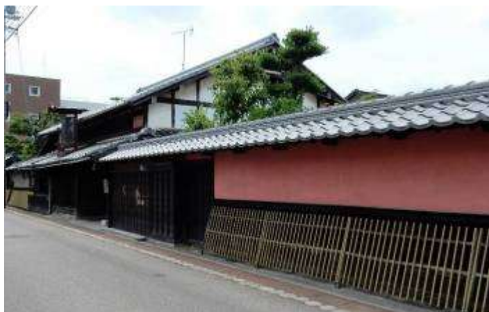
練屋町 小島家住宅 主屋 江戸後期の建築 朝鮮伝来の忍冬酒を慶長二年から醸造する。 朝鮮宮殿建築を模し、建物外壁をベンガラ壁とする。 座敷棟の庭園は慶長二年、古田織部の作庭である。 復原調査は本会の技術指導による。
